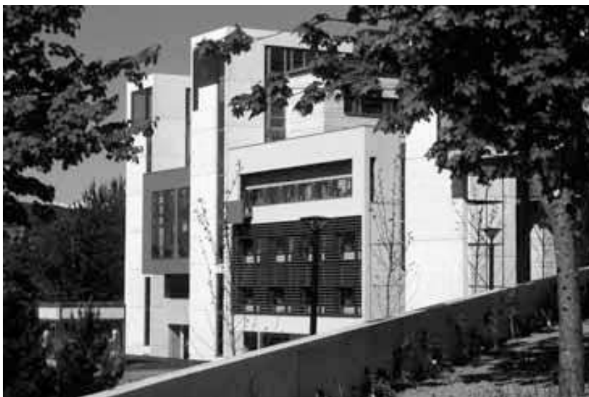
Realfagsbygget ved NTNU (foto: Mentz Indergaard).
