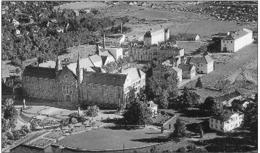
NTH i 1952 da SINTEFs ledelse holdt til i "Kjelhuset" v/skorsteinen som ruver høyest.
