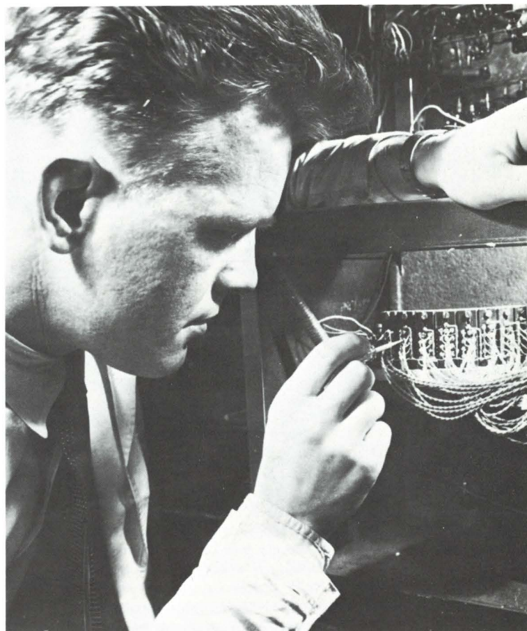
Kjell Kveim, nå sjef for Elektrisk Bureau, kobler ledninger på Nusse, en av de første norske datamaskiner. Foto: SIs fotoarkiv.
